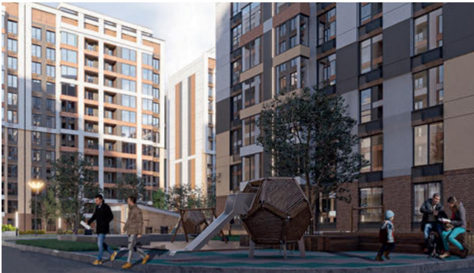
В основе лежит монолитная технология строительства, наружные стены выполнены из газоблока и утеплены базальтовой плитой. Современный качественный фасад.
