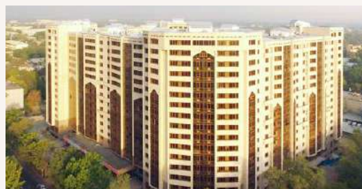
ЖК «ЕВРАЗИЯ» Строительно-монтажные работы г. Алматы, ул. Масанчи, 23 Срок завершения работ – 2015г.
