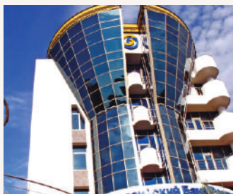
«ЕВРАЗИЙСКИЙ БАНК РАЗВИТИЯ» Строительно-монтажные работы г. Алматы, пр. Достык, 220 Срок завершения работ – 2004г.
