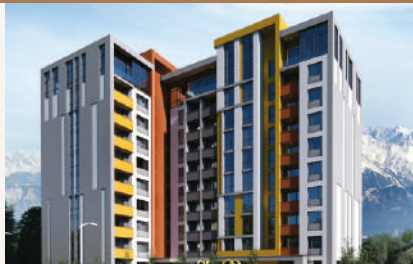
ЖК «CITY PARK» Строительно-монтажные работы г. Алматы, ул. Бузурбаева, 4Б Срок завершения работ – 2018г.
