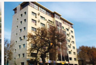
БЦ «GALIANOS» Строительно-монтажные работы г. Алматы, ул. Казыбек би, 117/86 Срок завершения работ – 2009г.
