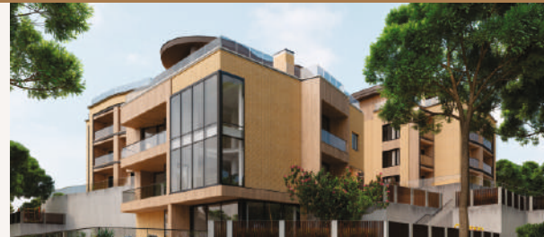
ЖК «JASMINE GARDEN» Строительно-монтажные работы г. Алматы, ул. Оспанова, 91 Срок завершения работ – 2019г.
