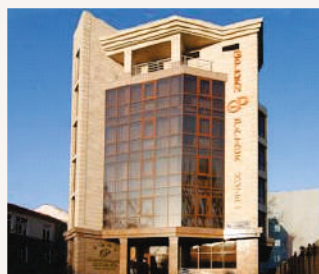
ГОСТИНИЧНЫЙ КОМПЛЕКС Строительно-монтажные работы г. Алматы, ул. Чайковского, 97 Срок завершения работ – 2010г.
