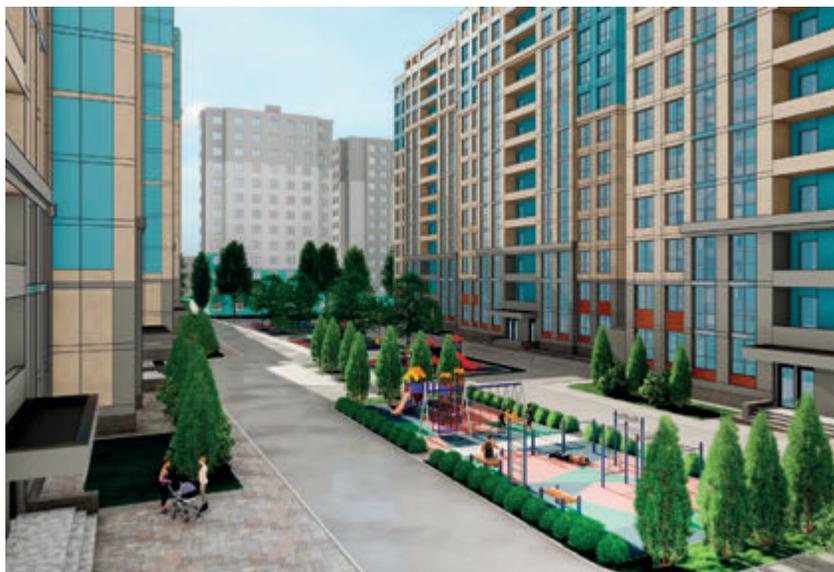
В основе лежит монолитная технология строительства, наружные стены выполнены из газоблока и утеплены базальтовой плитой. Вентилируемый фасад облицовывается фиброцементными плитами.
