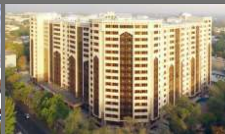
ЖК «Евразия» Строительно-монтажные работы г. Алматы, ул. Масанчи, 23 Срок завершения работ - 2015г.
