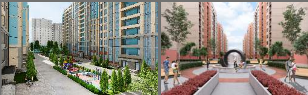
ЖК «12 МЕСЯЦЕВ» Строительно-монтажные работы. г. Алматы, ул. Макатаева, 127/26 Срок завершения работ - 2021г.
