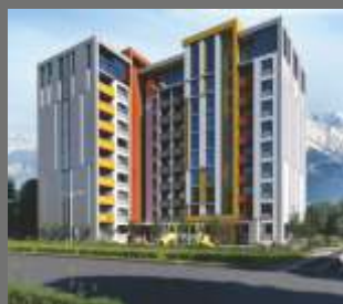
ЖК «City Park» Строительно-монтажные работы г. Алматы, ул. Бузурбаева, 45 Срок завершения работ - 2018г.
