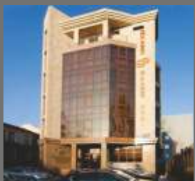
Гостиничный комплекс Строительно-монтажные работы г. Алматы, ул. Чайковского Срок завершения работ - 2010г.
