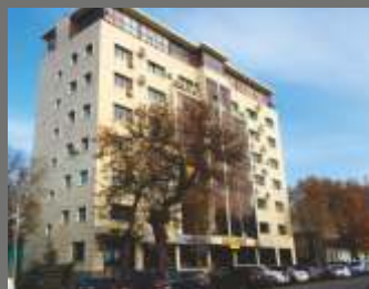
БЦ «Galianos» Строительно-монтажные работы г. Алматы, ул. Казыбек би, 117/86 Срок завершения работ - 2009г.
